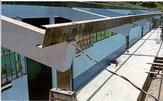
Foto 3: Cubierta delantera, parte externa.
