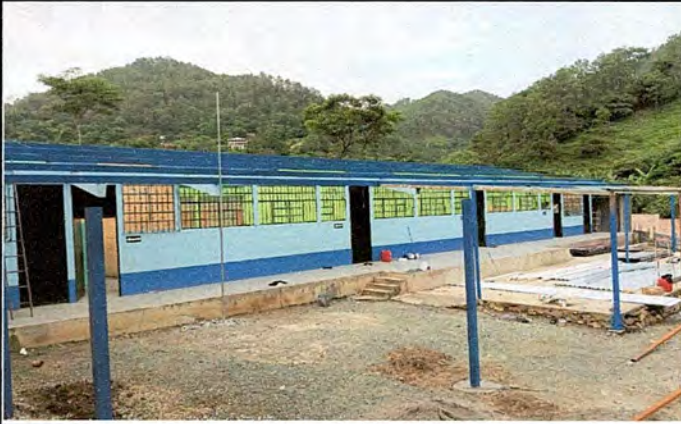
Foto 1: Vista panorámica del techo a sustituir.
