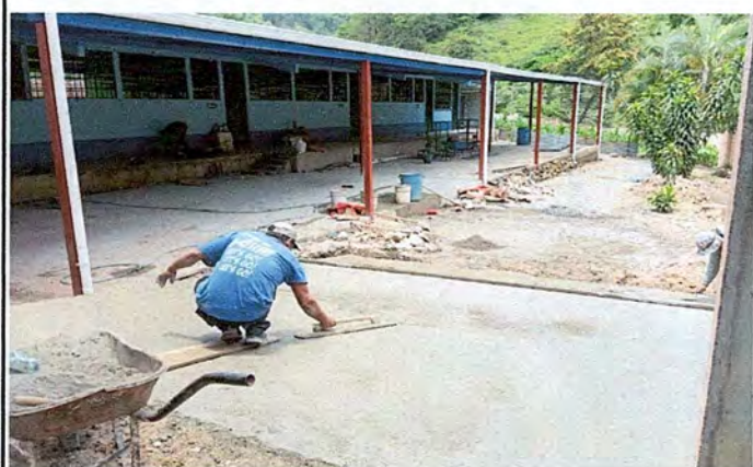
Foto 3: Cubierta delantera, parte externa.
