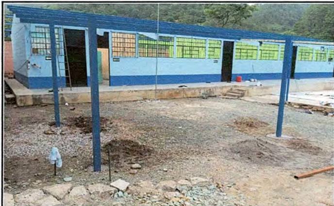
Foto 1: Vista panorámica del techo a sustituir.
