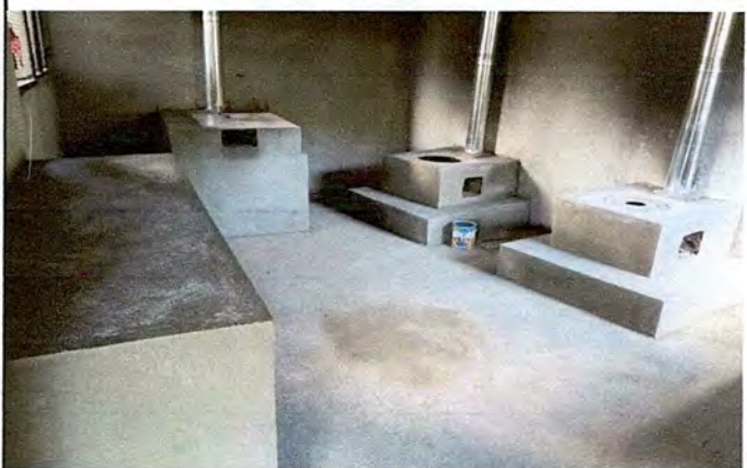
Foto 4: Cubierta dañada de la parte interna.
